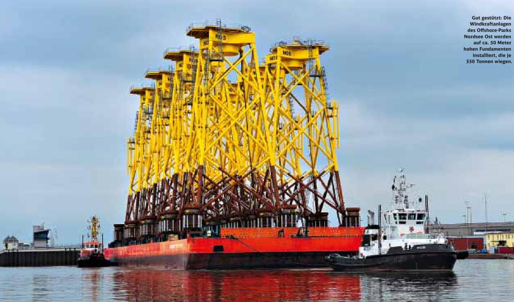
Gut gestützt: Die Windkraftanlagen des Offshore-Parks Nordsee Ost werden auf ca. 50 Meter hohen Fundamenten installiert, die je 550 Tonnen wiegen.
